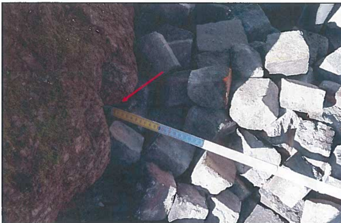
Foto3: il metro inserito all'interno del foro alla base è penetrato senza ostacoli fino a 90 centimetri.
